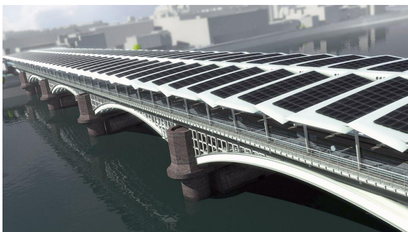
Imagen, propiedad de Network Rail, de la futura instalación de Blackfriars
